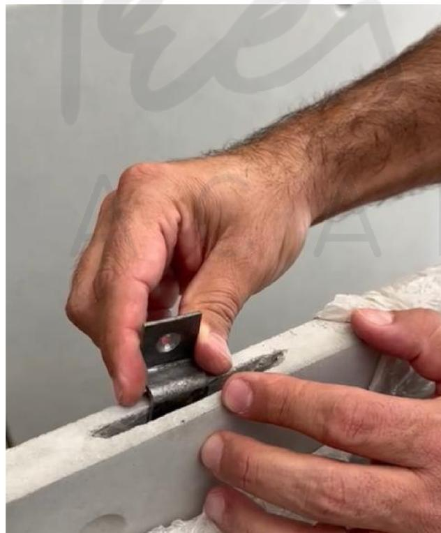
O chumbador metálico é encaixado no talho, fixado na parede com parafuso e posteriormente "escondido" por peça a ser fixada sobre ele.
